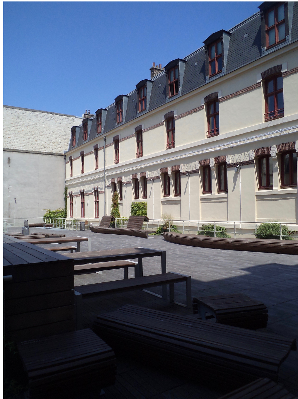
Terrasse du premier étage
