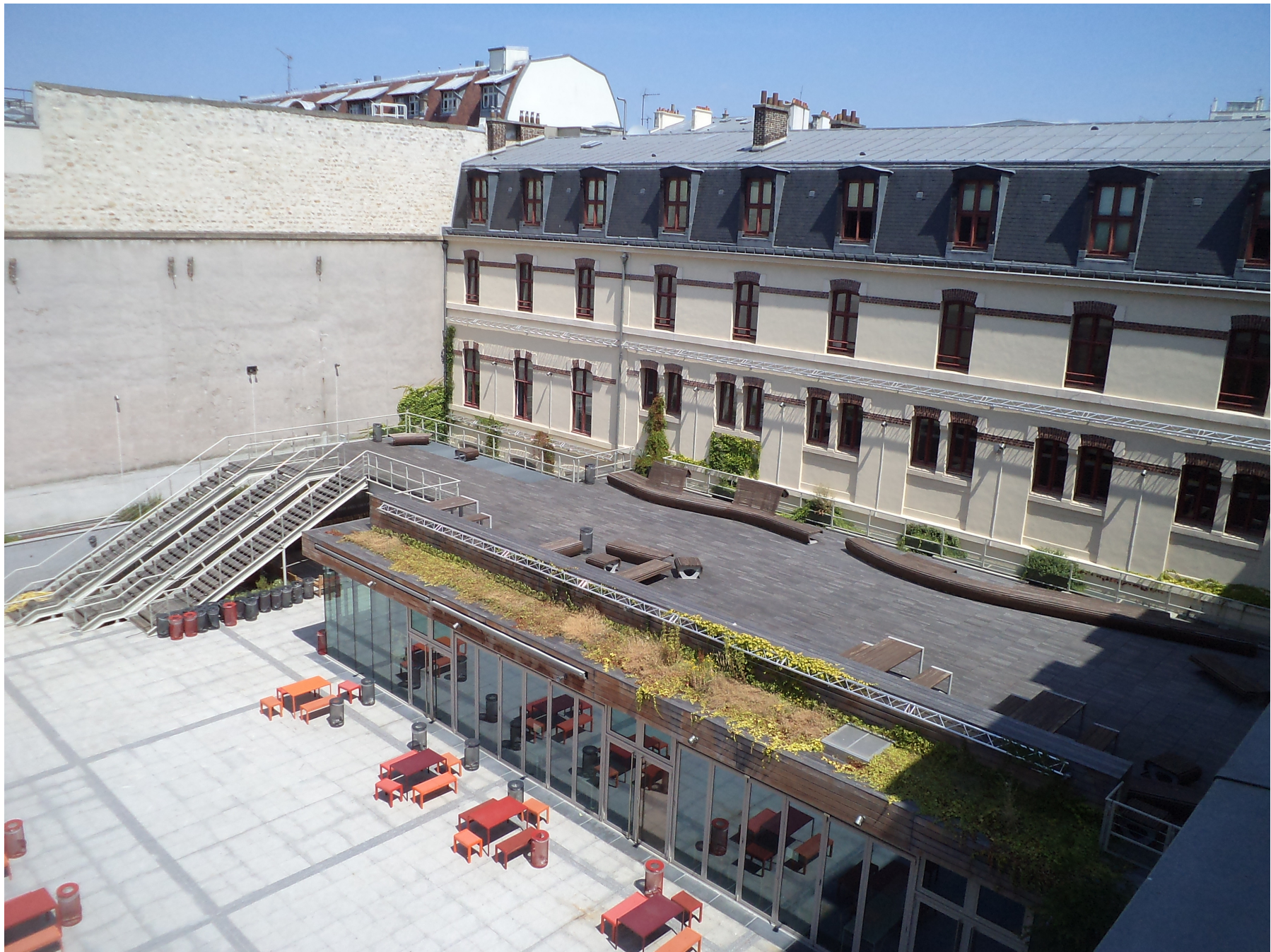
Vue du troisième étage, cafétéria
